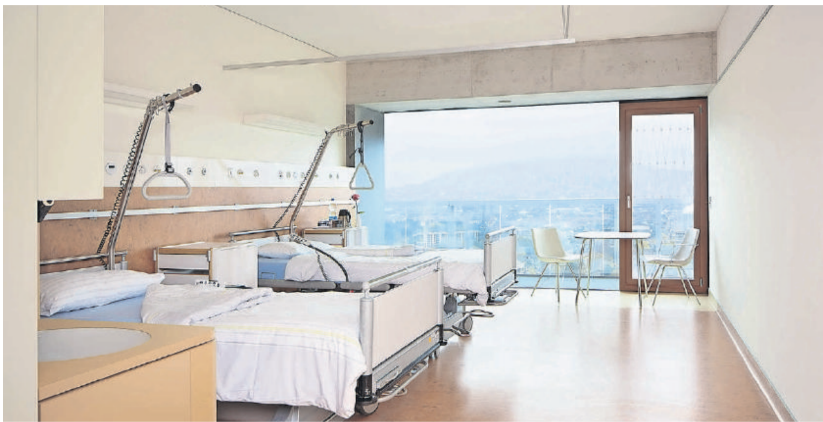
Die Decken aus Lehm in den Patientenzimmern des Triemlispitals sind optisch von einer Betondecke kaum zu unterscheiden. HOCHBAUDEPARTEMENT DER STADT ZÜRICH
